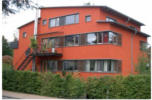
Rotes Haus, Hamburg Groß Flottbek (1999) Architekt: Loosen, Rüschoff+Winkler, Hamburg Foto: Weeber+Partner
